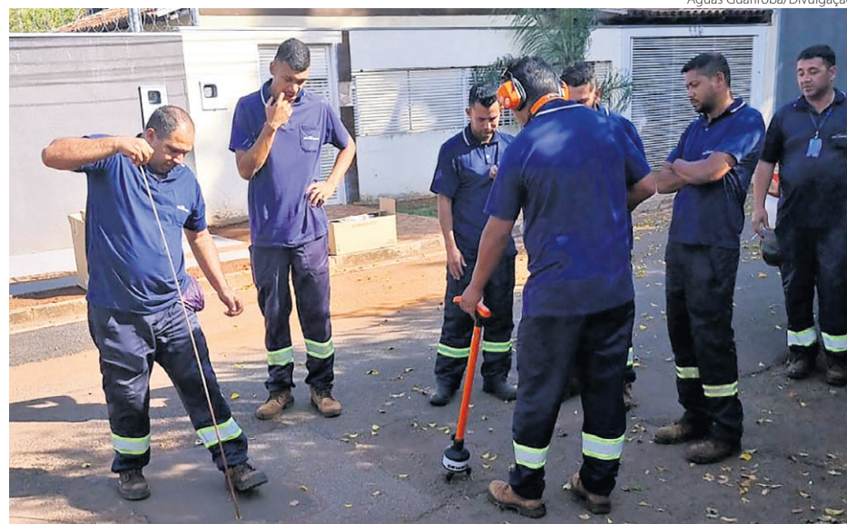
Equipe de geofonamento da Águas Guariroba em atividade contra os vazamentos ocultos
