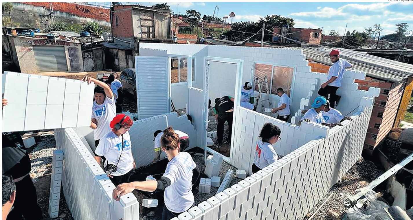
Casas são erguidas com blocos de polipropileno reciclado, produzidos após a coleta, separação, limpeza, trituração e injeção do plástico
