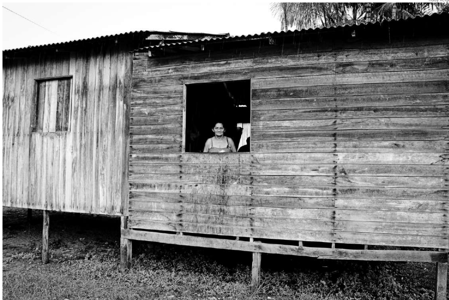
Famílias no arquipélago do Marajó, no Pará, vivem em habitações insalubres e precárias, sob o risco constante de inundações e desabamentos
